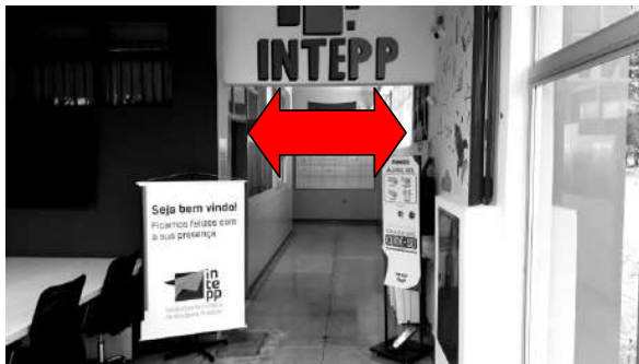
Imagem 4 - Neste vão será instalada a nova porta blindada de acesso Coworking - Agosto 2021
