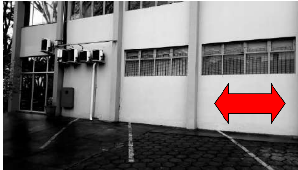
Imagem 12 – Local nova porta de acesso - Agosto 2021
