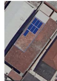
Cubatão 0002 – Gerador Fotovoltaico de 4,13 kWp (aprox. 402 kWh/mês)
