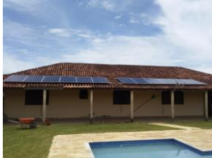
Juquiá 0051 – Gerador Fotovoltaico de 5,52 kWp (aprox. 538kWh/mês)
