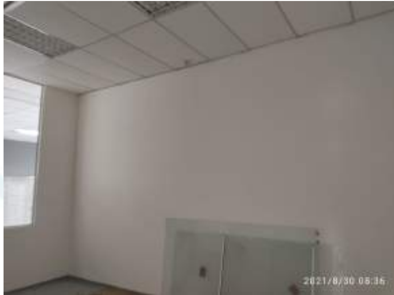
Foto 05 – Área interna do local
