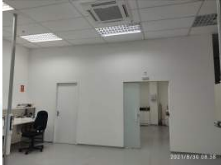
Foto 11 – Área interna do local
