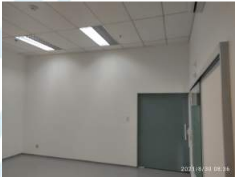
Foto 04 – Área interna do local
