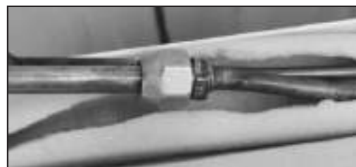
FIG. 28 - CONEXÃO DA LINHA DE SUÇÃO DA UNIDADE EVAPORADORA
