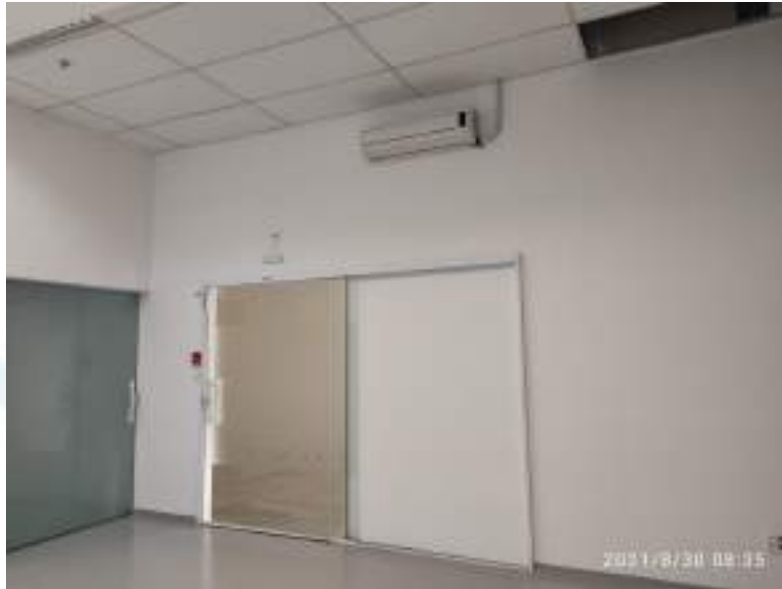
Foto 03 – Área interna do local - acesso
