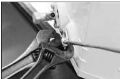
FIG. 25 - FIXAÇÃO DA PORCA
