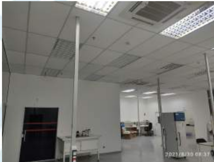
Foto 10 – Área interna do local
